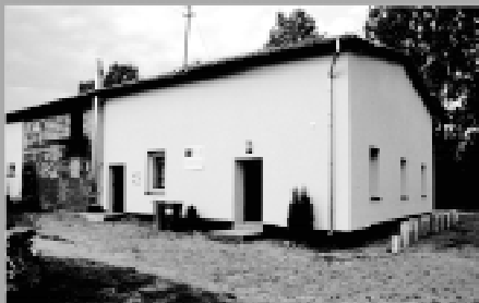
Odremontowana świetlica wiejska w Liszkówku. Dawna część zabudowań majątku Witzlebenów
